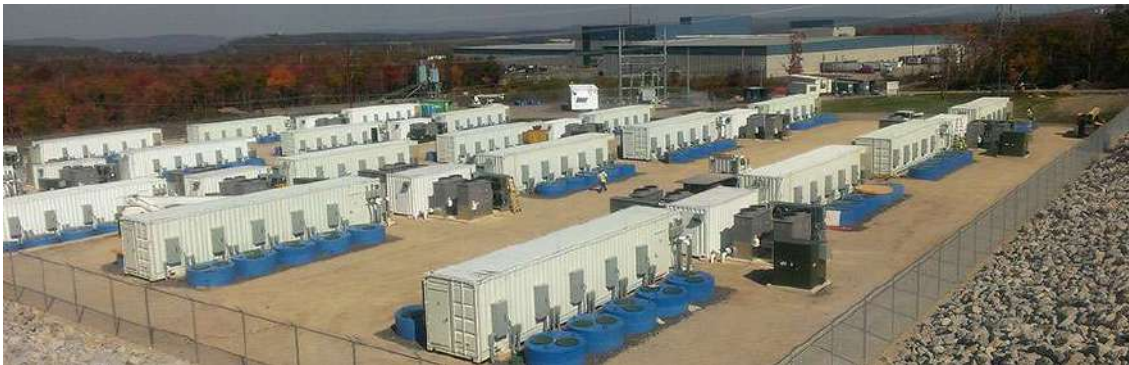
Hình 42: Ảnh nhà máy bánh đà hoạt động thương mại tại PJM, Hazle, Pennsylvania. Nhà máy có 200 mô-đun bánh đà chôn dưới đất phía hai cạnh bên container. Nhà máy cung cấp dịch vụ điều tiết tần số công suất 20 MW cho PJM, đi vào hoạt động đầy đủ công suất tháng 7/2014 [6].
