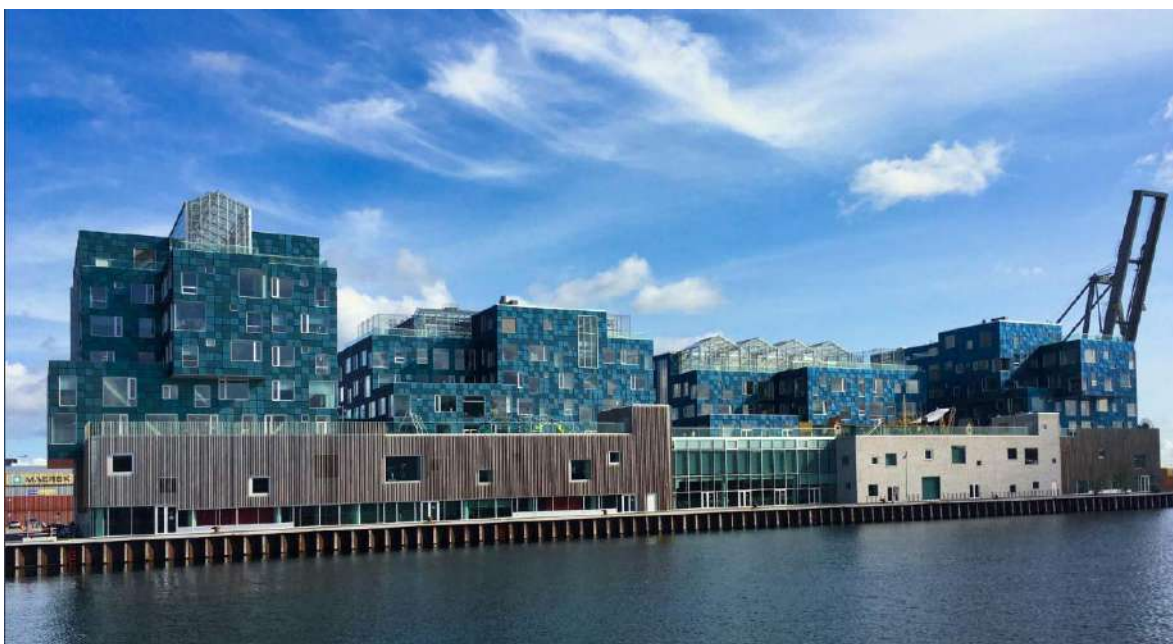
Hình 45: Mặt tiền bằng tấm quang điện tại Trường Quốc tế Copenhagen [24].
