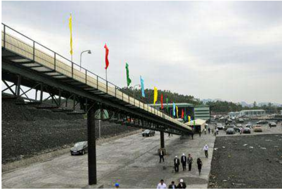
Hình 32: Hệ thống băng tải cấp than cho NMNĐ Mạo Khê
